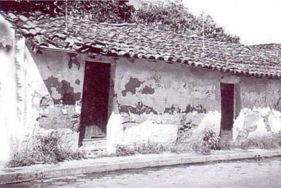
Construida con una estructura de cubierta de madera portante, con piezas de sección cuadrada y techo de troncos de palma en traslape. Las paredes de **tabique**.
