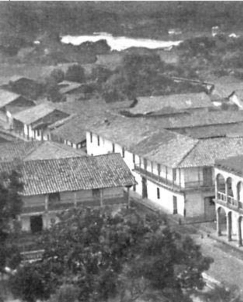
Una variante a esta tipología, fue la vivienda en doble altura con balcón continuo, construido de forma similar a la de una planta, con maderos y bovedilla en el entrepiso.
